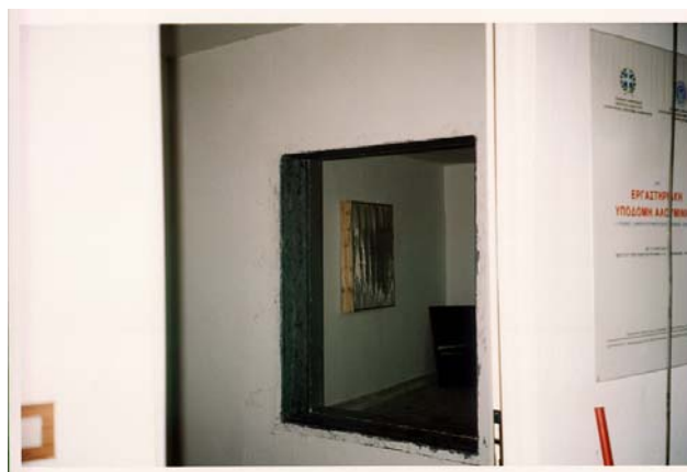
Το νέο άνοιγμα στους θαλάμους για την τοποθέτηση δοκιμών κουφωμάτων και υαλοπινάκων.
