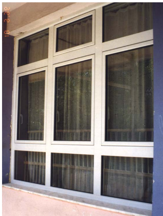
Φωτογραφία του ηχομονωτικού κουφώματος του σχολείου
